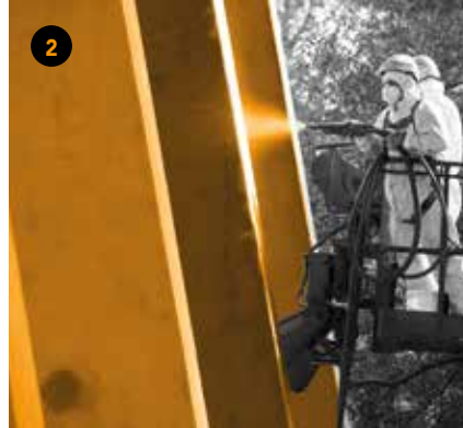
Réparation de béton
